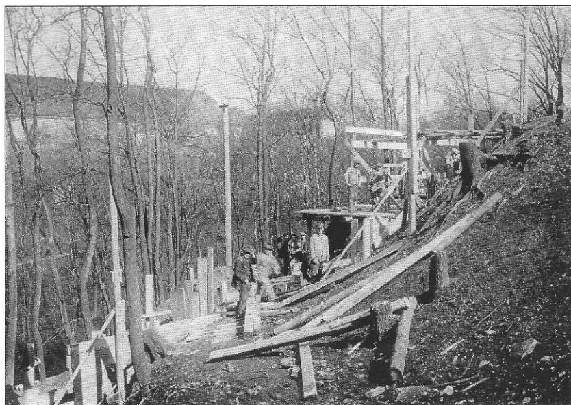
Obr. 2/5: Praha – Hrad, hradní nádvoří a svah Jelení příkopu. Hloubení sond v místě dnešní tzv. Plečnickovy lávky v roce 1930. Č. neg. 1307.
